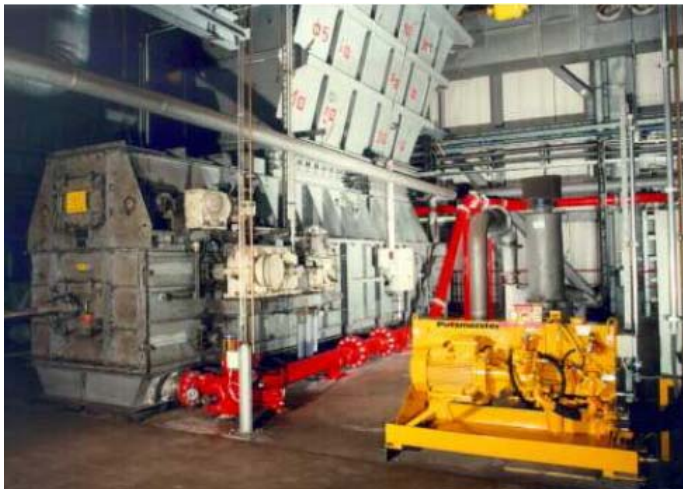
Подача осадка на сжигание с применением тактовых клапанов
