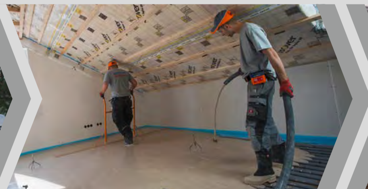
Укладка наливного самовыравнивающегося пола (TransMix 3200) либо (TransMix 5500) с помощью пульта дистанционного управления
