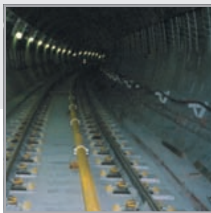
Система Zentrifix® для надёжной прокладки горизонтальных трубопроводов
