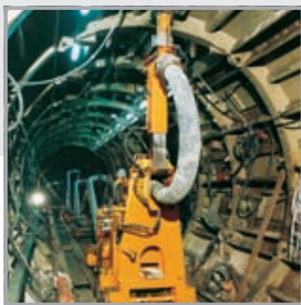
Бетонные работы в туннеле с использованием гибких трубопроводов SK в виде ножниц для труб
