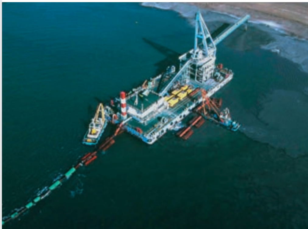
Три гигантских поршневых насоса KOS 25100 и 25200 перекачивают вынутый грунт при осушении прибрежной полосы в Японии. На созданном таким образом искусственном острове сегодня находится аэропорт Нагойя.
