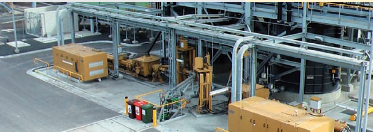
Насосная станция для подачи летучей золы и зольного остатка KOS 25100 (Коган-Крик, Австралия)
