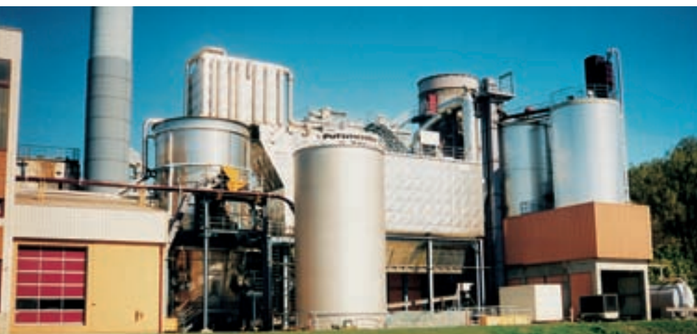
Участок приёма шлама очистных сооружений, включающий приёмный и штабельный бункеры. Для сжигания постороннего шлама на главной очистной станции Стуттгарт-Мюльхаузен, Германия.
