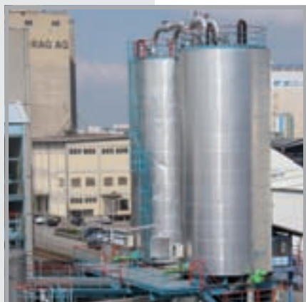
2 штабелных бункера (изолированные) на 200 м³ каждый для накопления шлама (Про-Рено, Швейцария)
