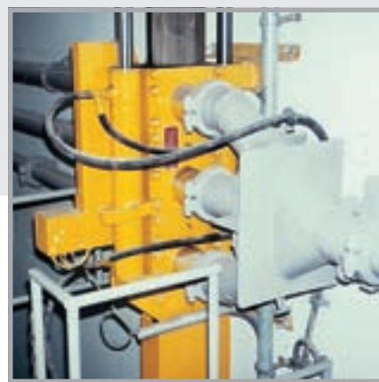
Шибер трубопровода для трёх различных линий транспортировки
